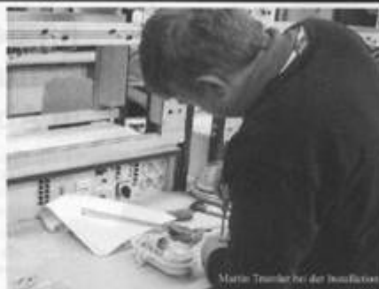
Martin Trummer bei der Installation
